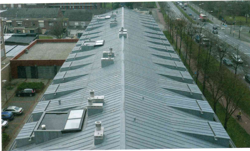
Het dak in kwestie
